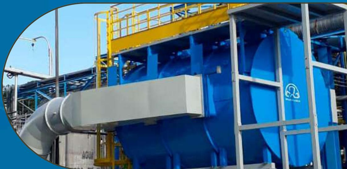
O filtro de carvão ativado possui características únicas que auxiliam na eliminação de poluentes com alta concentração de odores. Com propriedades especiais, ele é utilizado como sistema de filtragem industrial, removendo compostos orgânicos voláteis, entre outros poluentes gasosos provenientes das operações em indústrias alimentícias, químicas, farmacêuticas, entre outras.
